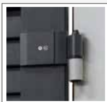
Klobenmontage auf Zargenrahmen
